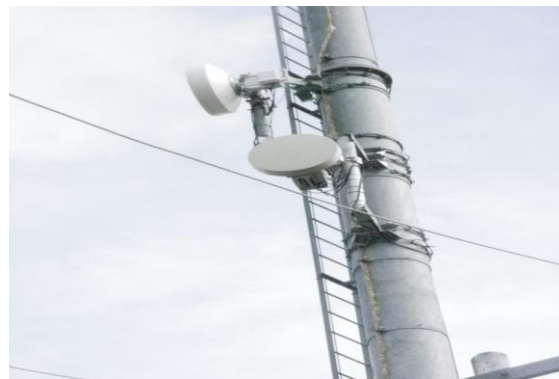
Figura 7 Reflectores parabólicos de la antena monopolo
