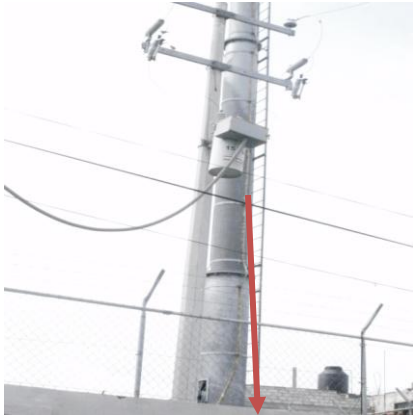
Figura 6 Escalerilla de la torre
